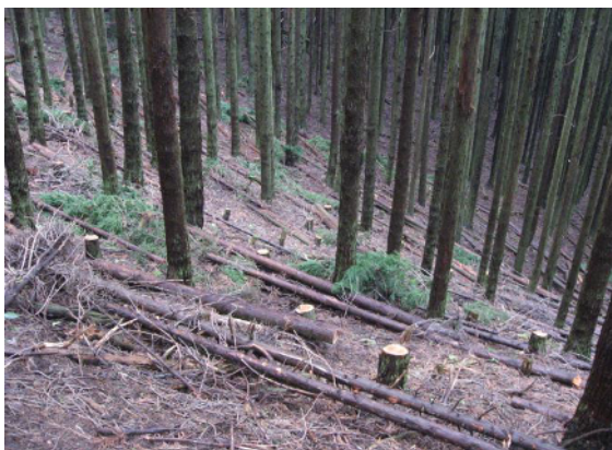
急傾斜地における伐採木を用いての土留め工
