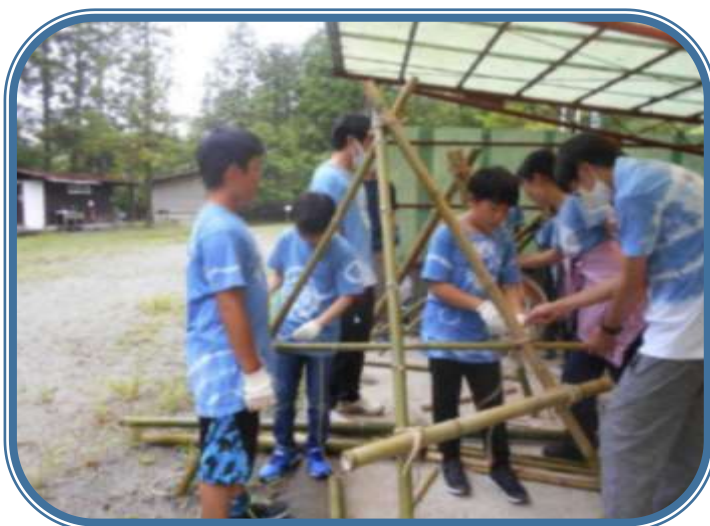
竹を組んで縄で固定します。倒れないように、高さを合わせてくくりつけました。
