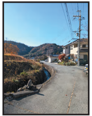
川治いの一部 川側にフェンス無し
