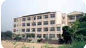
第1次避難所：広野小学校
