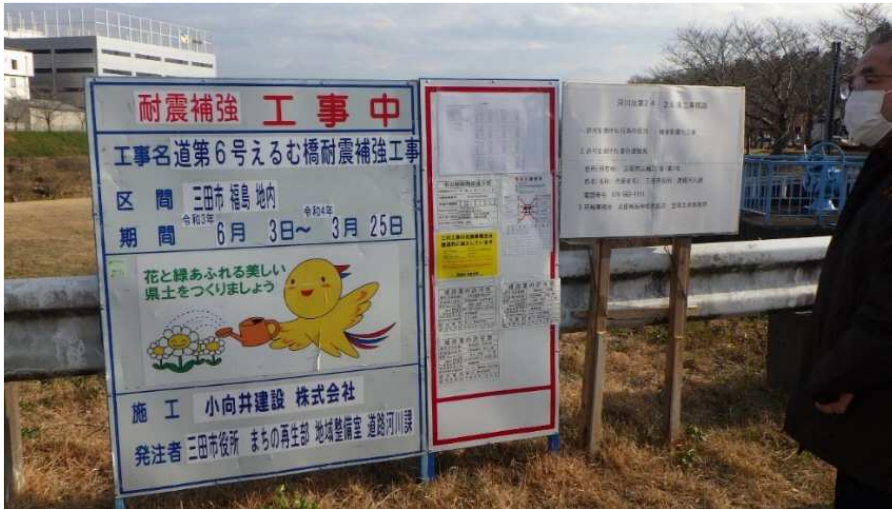
【写真－6 工事看板設置状況】
