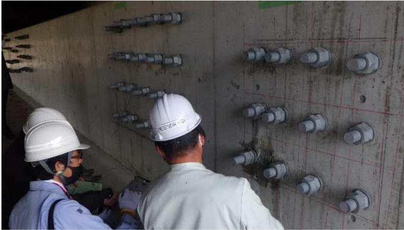
【写真－3 現場監査 立会状況－1】
