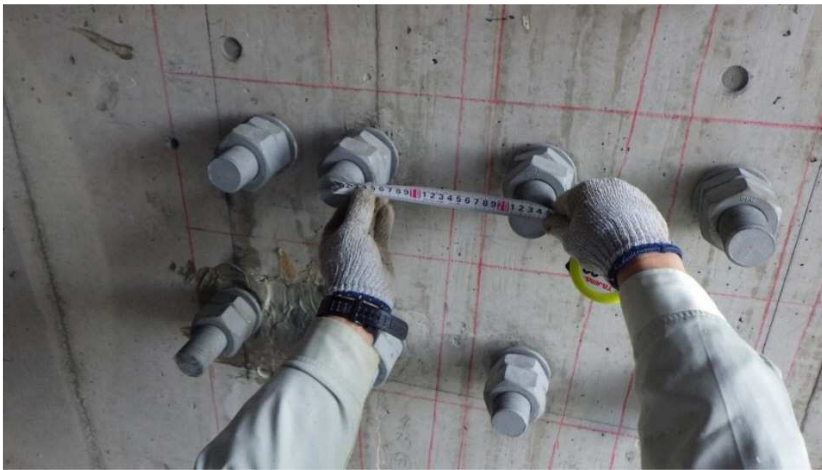
【写真－4 現場監査 立会状況－2】
