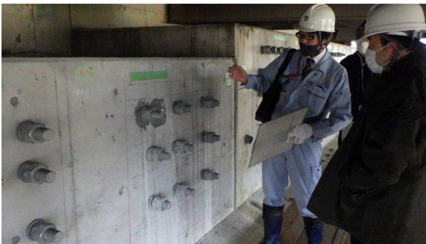
【写真－5 現場監査 立会状況－3】
