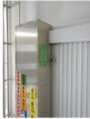
設備 (扉上部) を養生テープで補強
