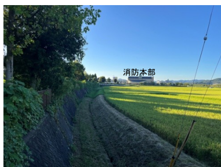
④水路と敷地の東境界付近
