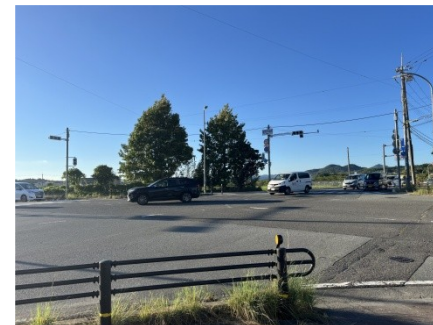
⑨総合庁舎前交差点から 北西方向を望む
