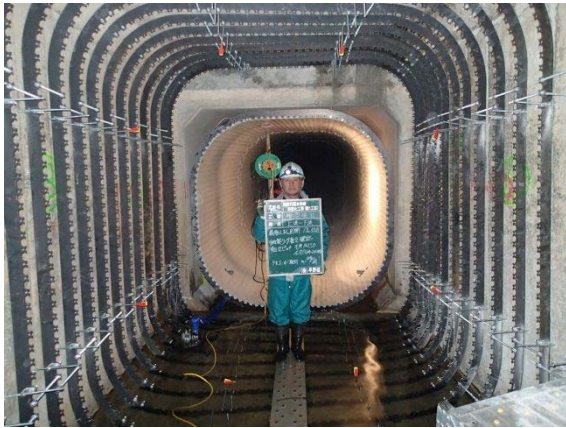
図 3-6. 相野川雨水幹線耐震化工事 (施工中写真)
