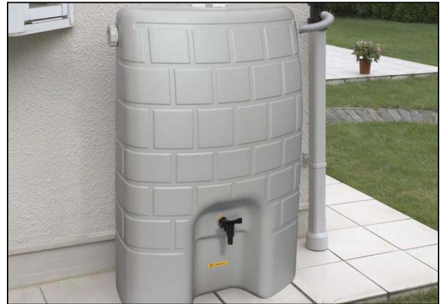
図 3-4. 雨水貯留タンク
