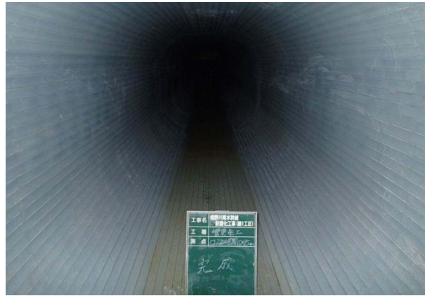
図 3-7. 相野川雨水幹線耐震化工事 (完成写真)
