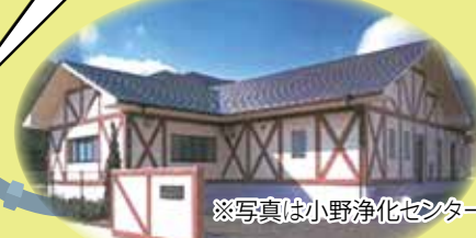
市営浄化センター
