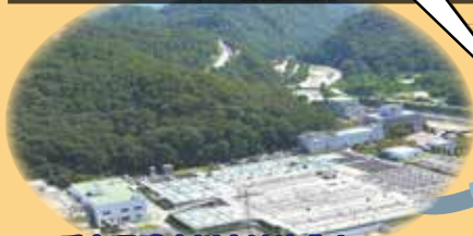
兵庫県武庫川上流浄化センター (神戸市北区道場町)
