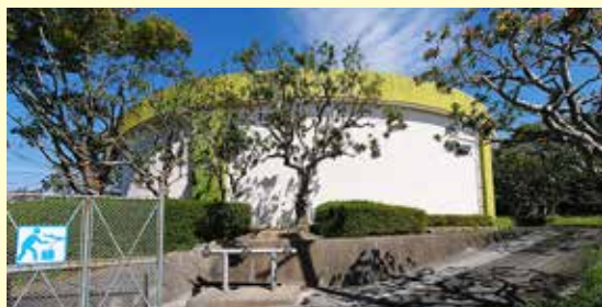
けやき台配水池▶
