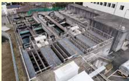
三田市天神 古城浄水場
