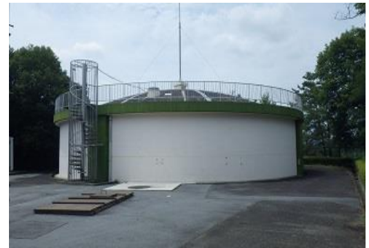
配水池 水道水を貯蔵する倉庫で、水の使用量に応じて水量を調整します。また、地震など災害時は給水拠点として利用します。
