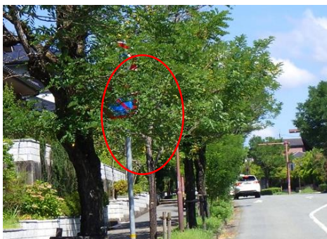
見通し不良や標識・照明等への枝かかりなど、支障を引き起こしている街路樹は剪定や撤去・更新等により対処します。
