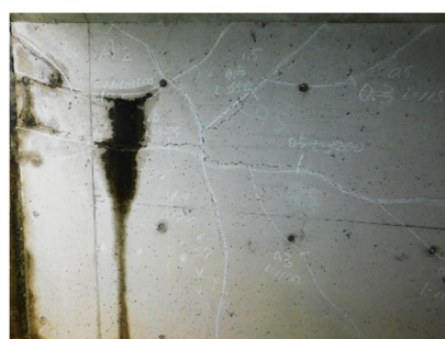
下部工にひびわれが見られます
