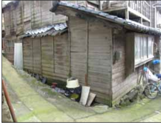
外壁が裸木造の例
