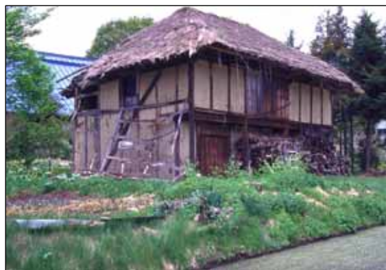
屋根材がワラの例
