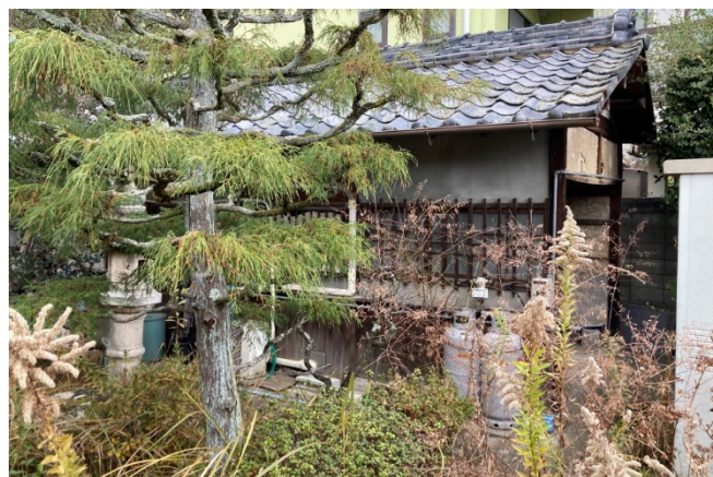
外観写真（通り土間庭に面する部分の南側）
