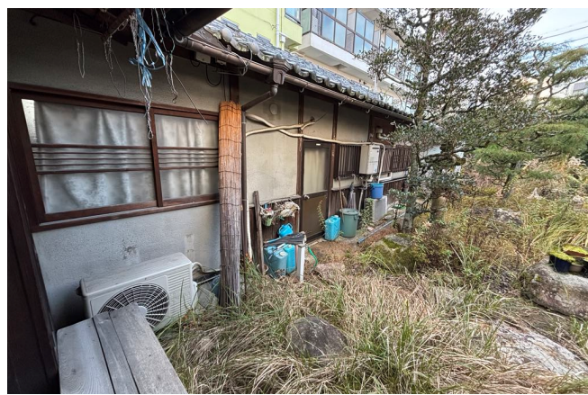
外観写真（通り土間庭に面する部分の西側）
