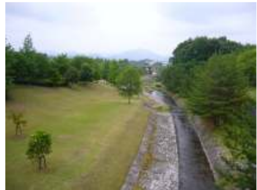
親水性を確保した護岸（平谷川）
