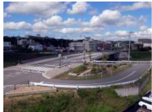
橋詰に配置されたポケットパーク(武庫川大橋)
