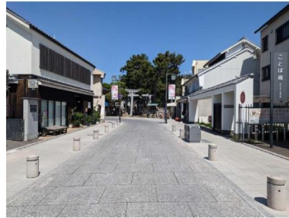
無電柱化整備状況（伊丹市）
