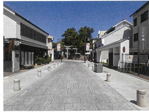
無電柱化整備状況 (伊丹市)
