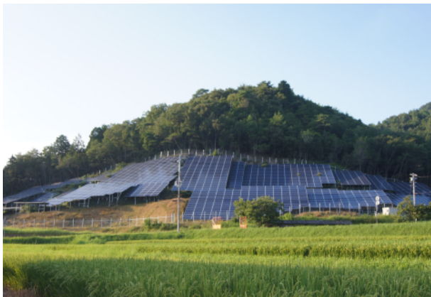
▲斜面地に無秩序に設置された太陽光発電施設
