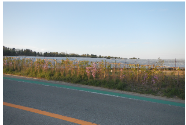
▲景観に配慮して修景された太陽光発電施設
