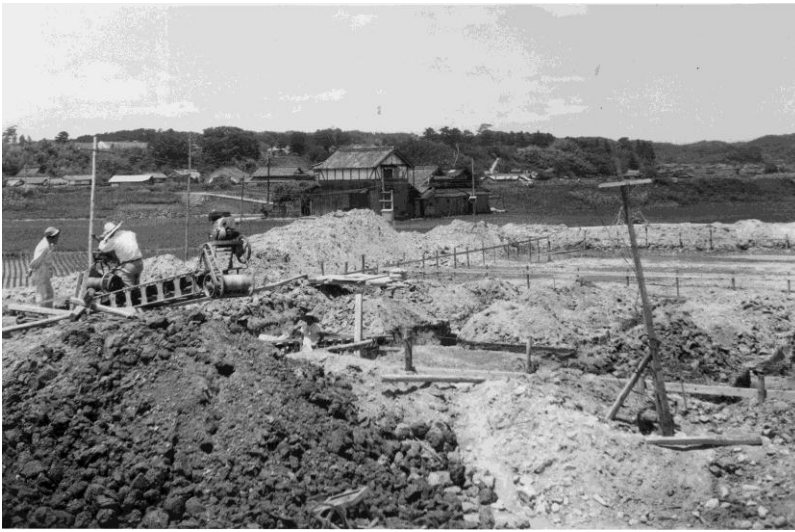
市役所建設地から武庫川を望む（昭和34年）
