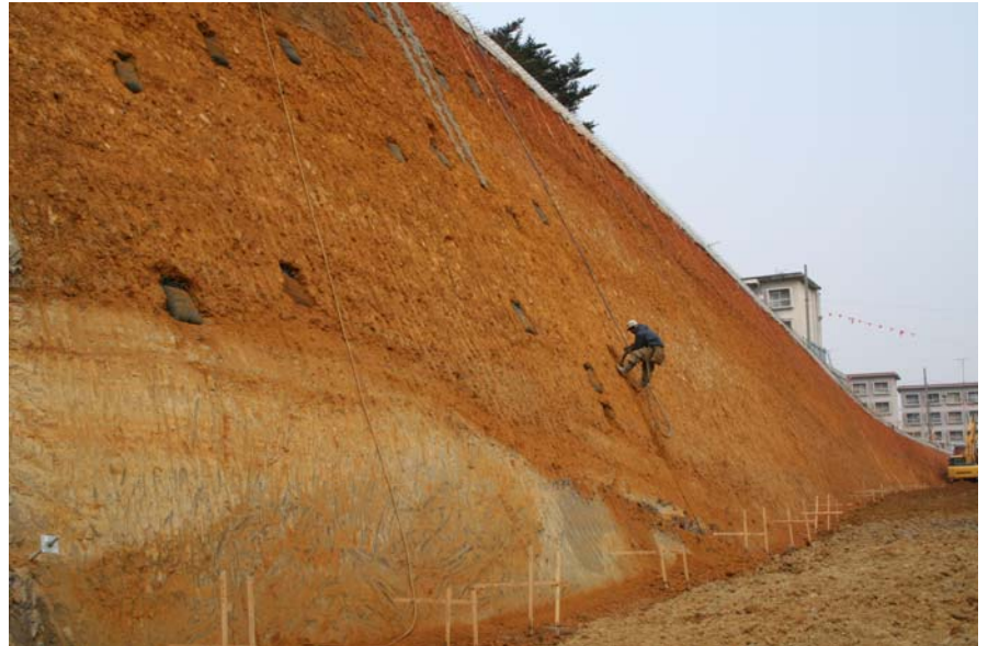
拡幅現場の地層断面
