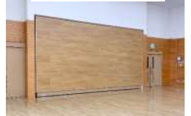
電動式壁面収納舞台
