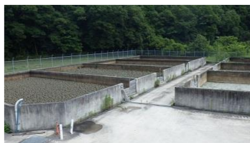
天日乾燥場 浄水場の沈澱池に堆積した泥は天日乾燥場に搬出され、天日による自然乾燥を行います。
