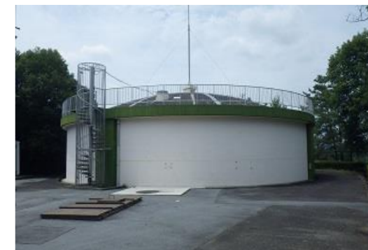
配水池 水道水を貯蔵する倉庫で、水の使用量に応じて水量を調整します。また、地震など災害時は給水拠点として利用します。
