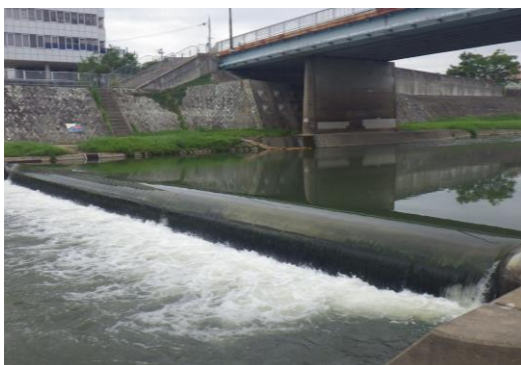
武庫川取水口 水位調整ができ増水・渇水時にも安定した取水が可能です。
