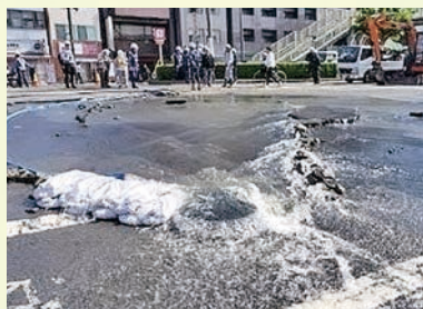
古い水道管が老朽化によって、ある日突然破損することがあります。 (令和7年4月京都市の事例)
