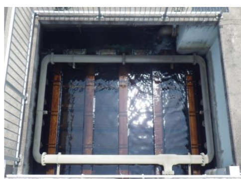
急速ろ過池 沈澱池で取り除けなかった小さなごみを砂の槽でこしてきれいな水にし、浄水池に貯めます。
