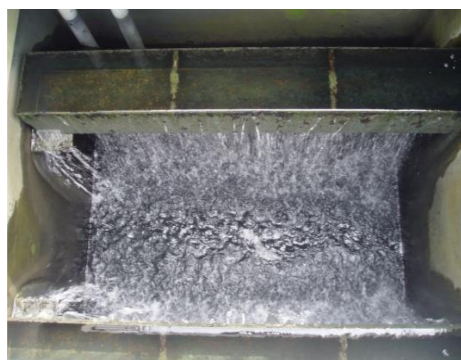
活性炭ろ過池 活性炭により有機物や臭気、有害物質等を除去します。
