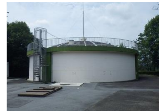
配水池 水道水を貯蔵する倉庫で、水の使用量に応じて水量を調整します。また、地震など災害時は給水拠点として利用します。
