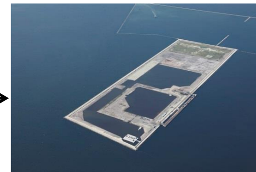
大阪湾埋め立て地 天日乾燥場で乾燥させた泥は大阪湾の最終処分場にて埋立処分を行います。
