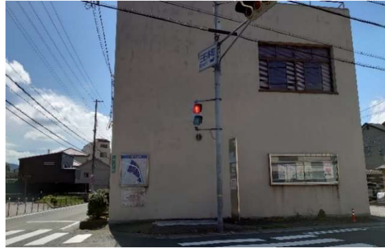
西から見る建物
