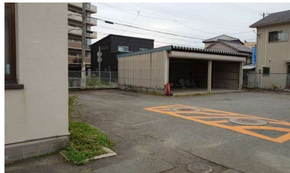
敷地奥の車庫棟
