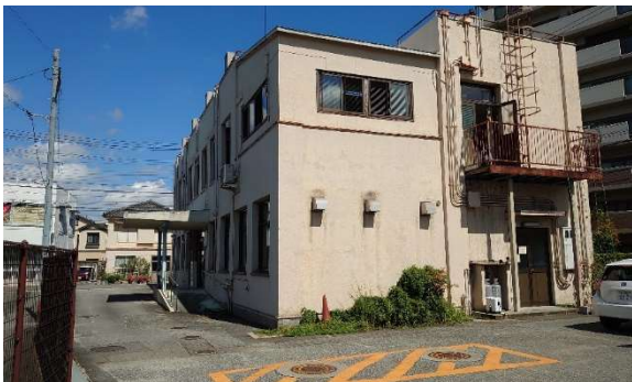
東から見る建物
