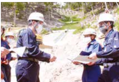
5月25日 水防・防災合同パトロールを実施。平成30年に発生した山腹崩壊の復旧工事を視察
